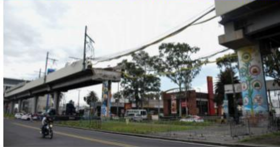
La CDMX y la Universidad Autónoma de Nuevo León informaron que se detectaron 21 nuevas grietas en el tramo elevado de la Línea 12 del Metro. (Cuartoscuro)
