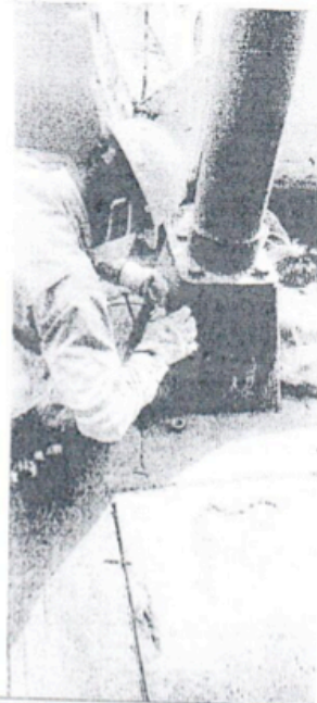
Imagen de Colocación de Luminaria
