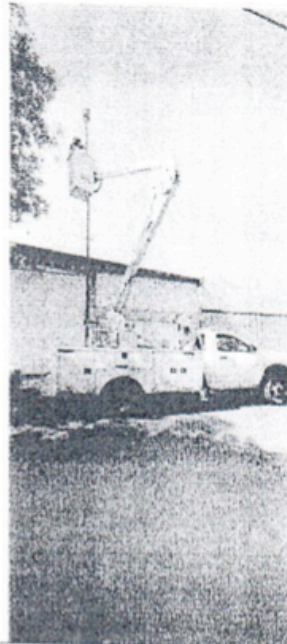
Imagen de Colocación de Luminaria
