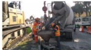
Colado de pila en apoyo 195
