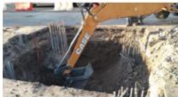
Excavación en apoyo 186
