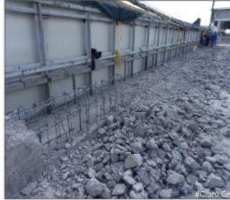
Demolición de muro en Claro Espejo.
