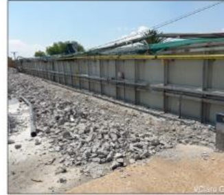
Muro demolido en Claro Espejo.
